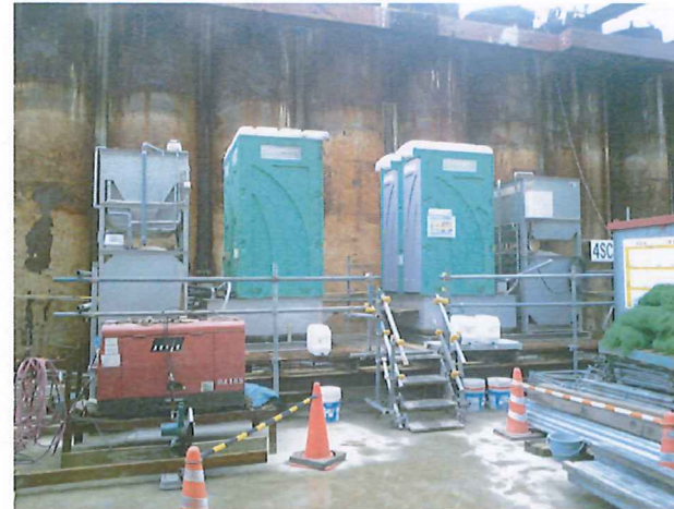
羽田空港再拡張工事現場 (清水建設)
