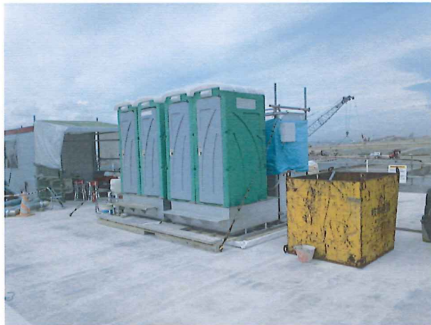
羽田空港再拡張工事現場 (鹿島建設)
