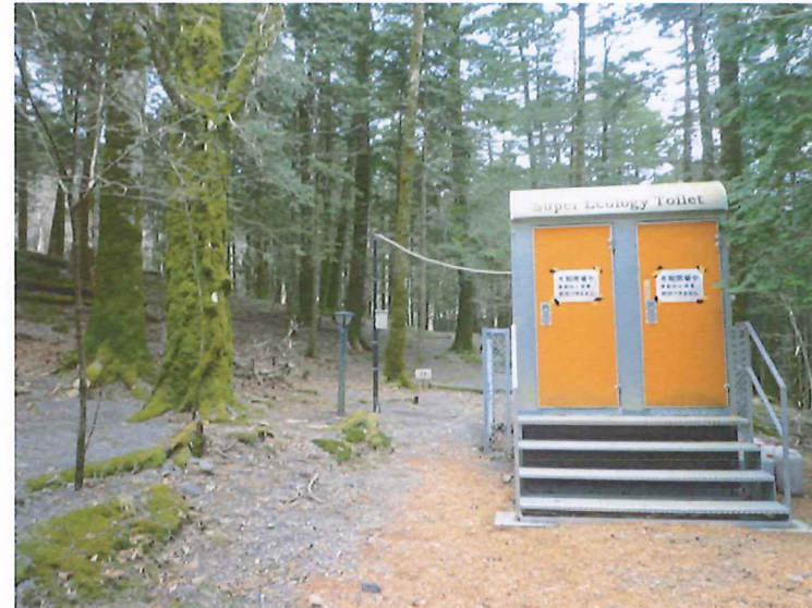
豊かな自然とのふれあい施設 県民の森 発注者：静岡県中部農林事務所 設置年月：平成22年4月
