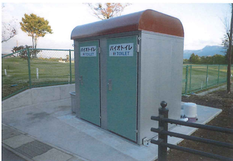
高根西ふれあい広場 発注者:御殿場市 市民協働課 設置年月:平成25年10月
